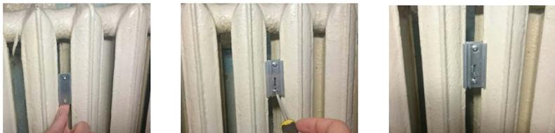
2. Удалить защитную крышку датчика температуры на задней части распределителя.
